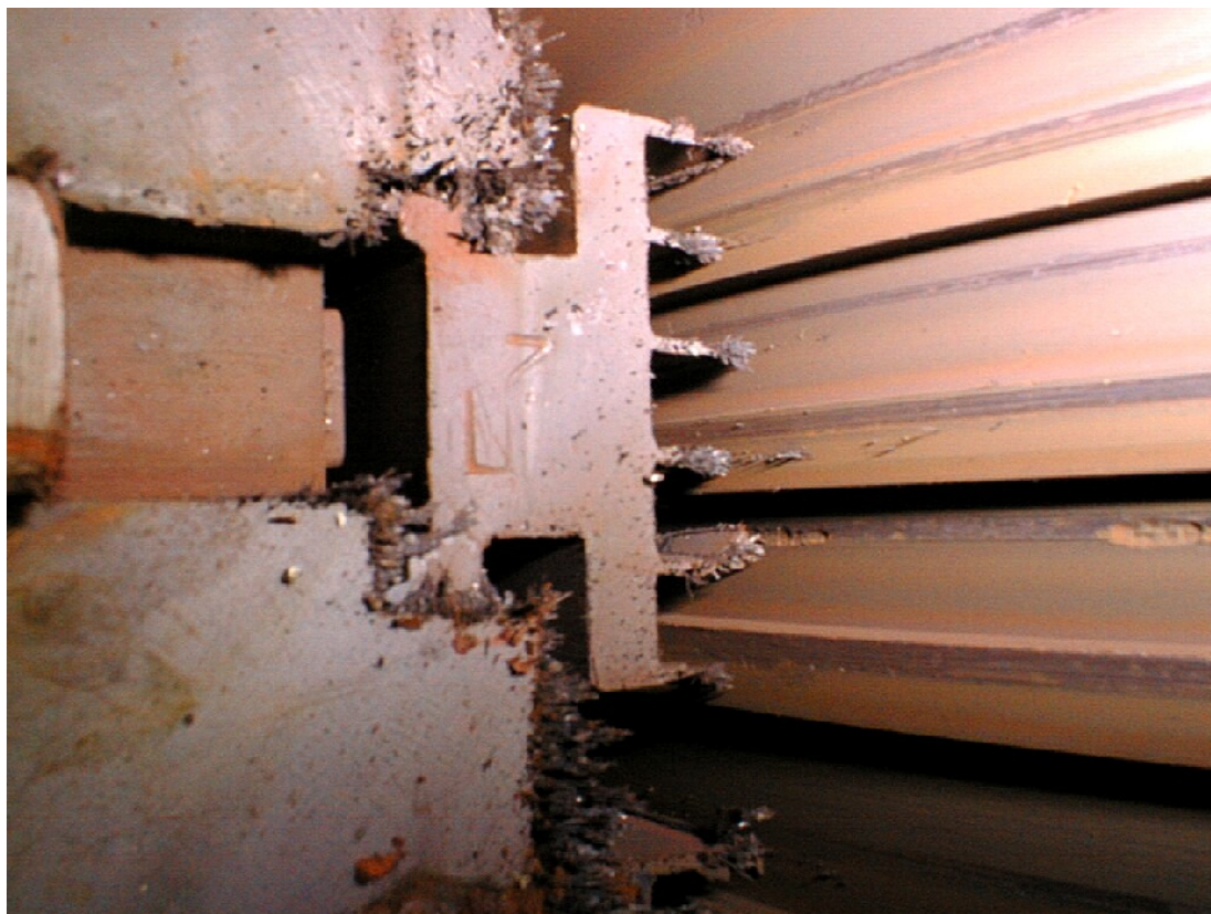
Рис. 3. Участок диафрагменного уплотнения с признаками электроэрозии канавок ротора
