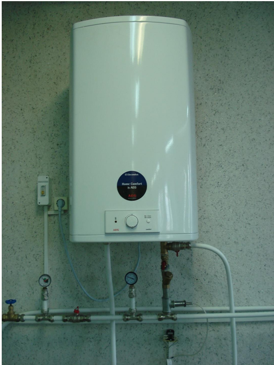
Рисунок 3.14 – Водоподогреватель ёмкостного типа
