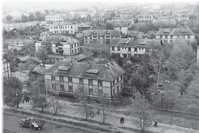
Рабочий поселок. Фото 1959 г. Ул. Рабфаковская, вид со стройки корпуса «Б» ИЭИ
