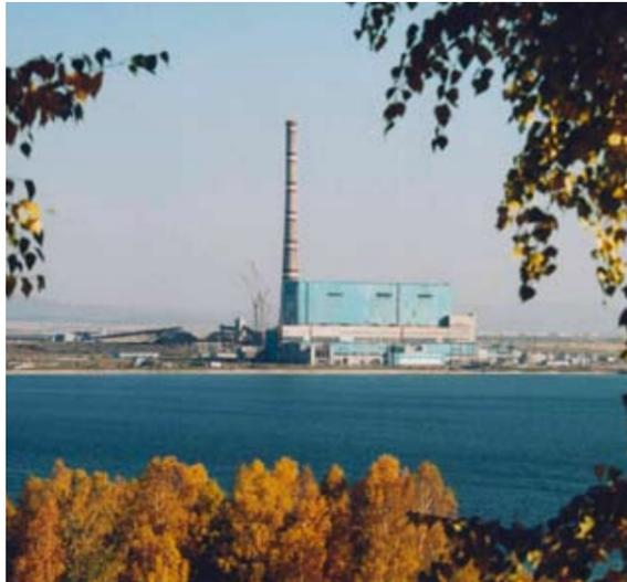
На Березовской ГРЭС-1 установлено два энергоблока мощностью 800 МВт с паровыми турбинами К-800-240-5 ЛМЗ и прямоточными однокорпусными котлами П-67 Подольского машиностроительного завода им. Орджоникидзе. Основным топливом для котлов станции является бурый уголь марки 2БР Березовского месторождения, при сгорании которого образуется зола,  $\text{NO}_x$ ,  $\text{SO}_2$ .
