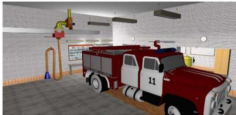
Рис.1 Применение технического устройства для удаления выхлопных газов из гаража пожарно-спасательной части
